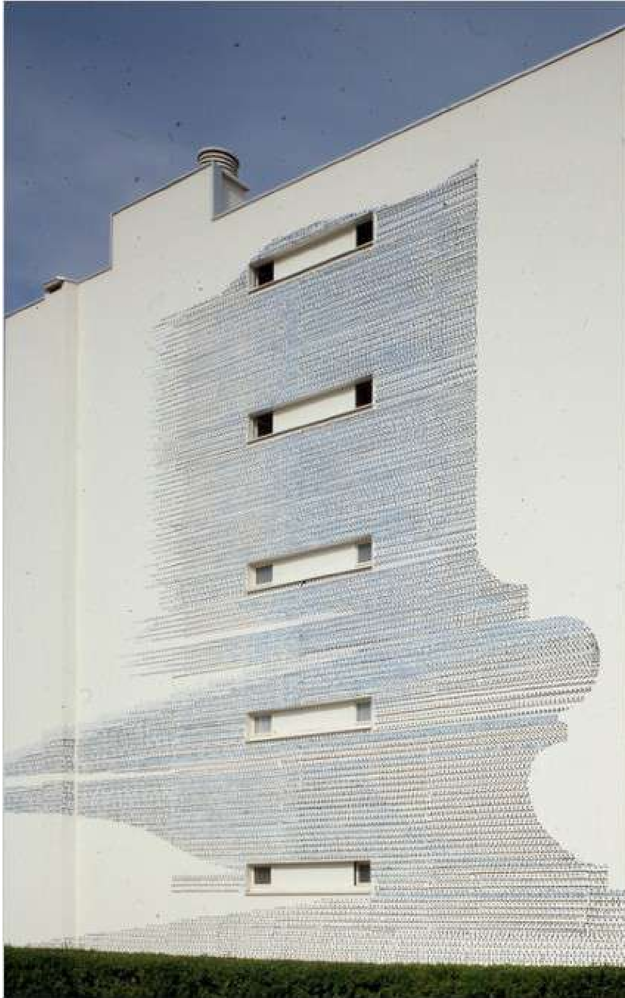
Photographies envoyées par les Barto + Barto, de l'état des lieux réalisé en 2014.
